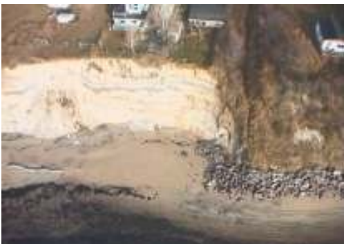
Figure 2 : Travaux d'enrochement et effet de bout
